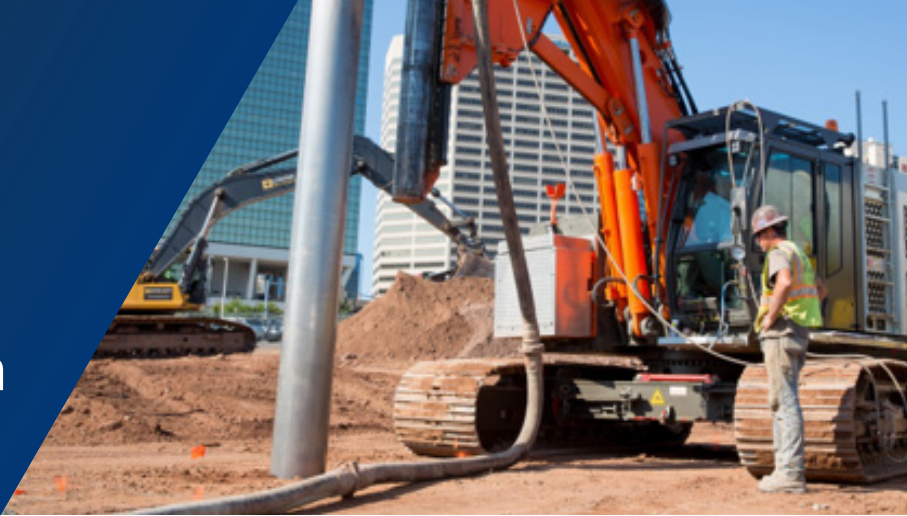
Geopier GeoConcrete®-Säulen (GCC)
